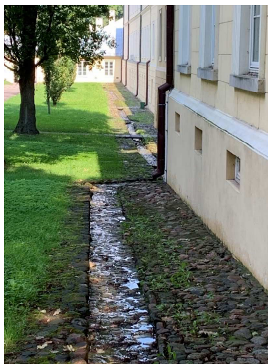
Zdjęcie 25 Przykład realizacji: powierzchniowe odprowadzenie wód opadowych do infiltracji w gruncie
