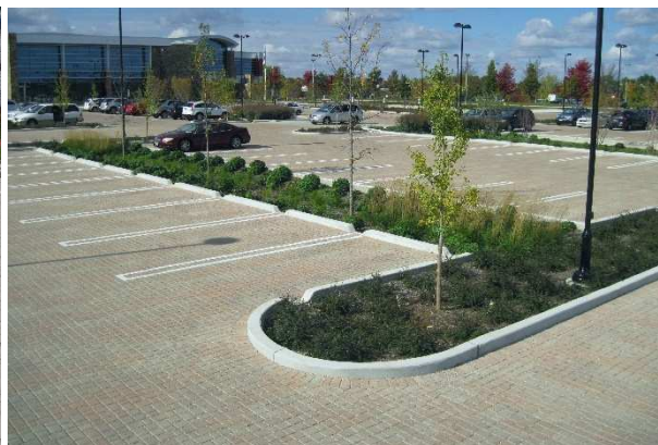
Zdjęcie 22: Przykład realizacji: elementy ZNI na parkingu
